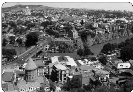
Obr. 3 – Pohled na koryto řeky Kury protékající centrem Tbilisi.
